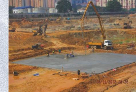
Betonun kütle halinde dökülmesi durumunda, herhangi bir andaki beton iç sıcaklıkları ve beton yüzeyi ile çevre arasındaki sıcaklık farkları betonu çatlattırmada önemli role sahiptir. Herhangi bir andaki, beton iç sıcaklığı ile beton yüzeyi arasındaki sıcaklık farkı 20-25°C'yi aşığında çatlaklar meydana gelebilmektedir.
